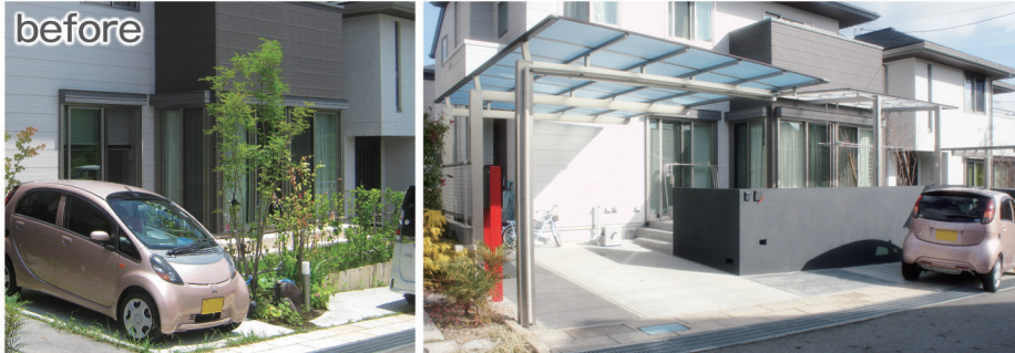
手入れが大変な樹木を整理して 樹脂フェンスを設置。 お庭の有効スペースがぐんと増えました。
